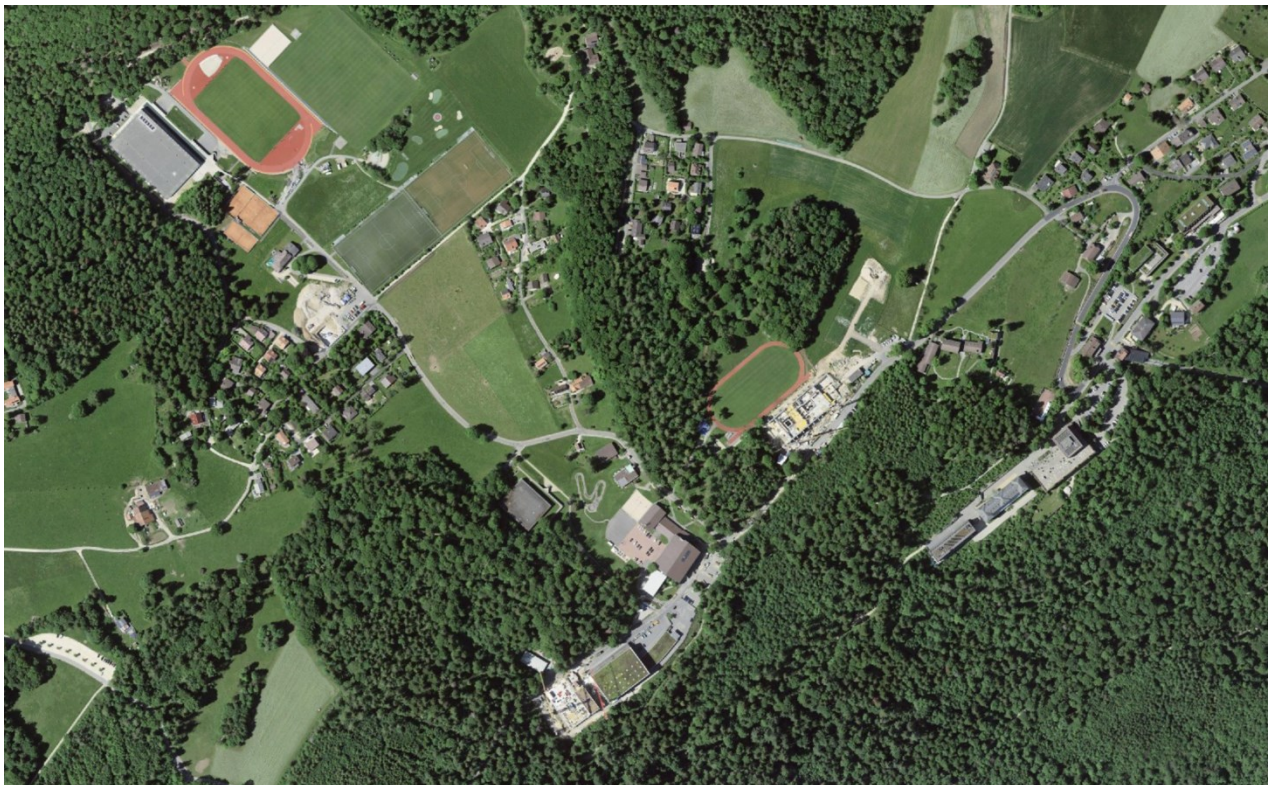
Vue aérienne du site de l'OFSP0 (nouvelle salle de formation et Haute école Place des Mélézes en construction)
