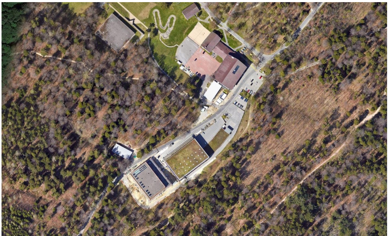
Vue aérienne du site de la centrale énergétique, Office fédéral du sport (OFSP0) à Macolin
